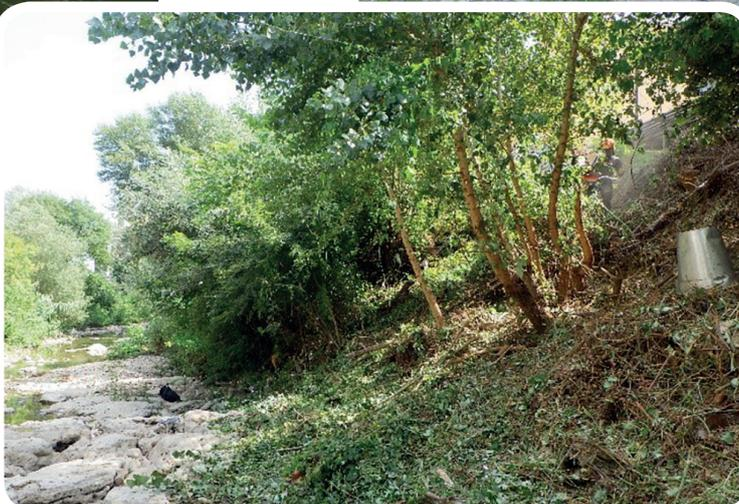
*Rajeunissement de la section d'écoulement sur l'ensemble d'un tronçon*
